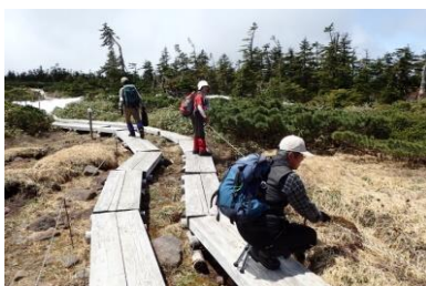
天狗岩―西吾妻小屋間の取付け
