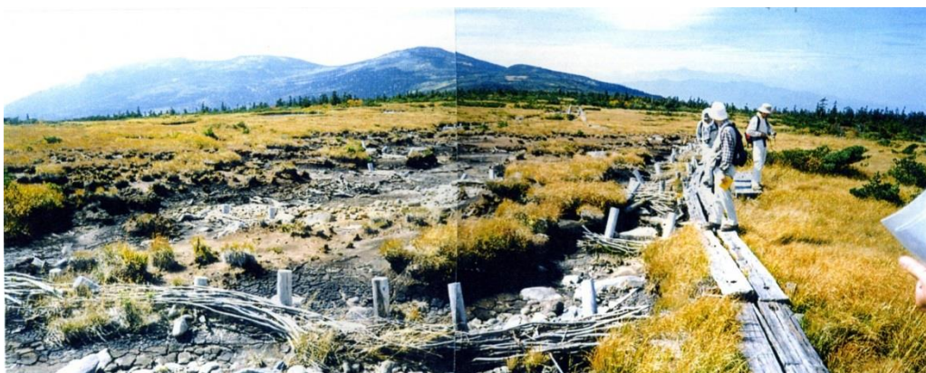
上に同じ頃 第2 植生回復区の惨状 古く危険な木歩道を放置した結果か？
