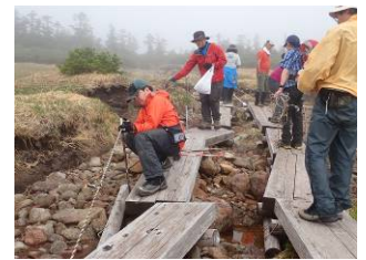
ロープ設置作業
