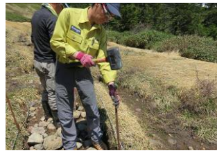
鉄杭補修は任せて
