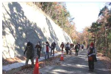
道路拡張後の羽山南道:趣は失われ、落石の危険性が高まりました
