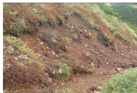
崩壊は進行中
