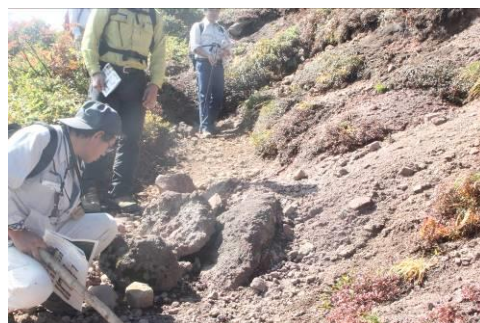
西大巓山頂直下の斜面崩壊
