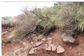
平坦部の崩壊
