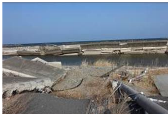
防波堤は壊れたまま
