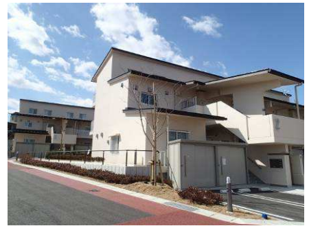
完成した災害公営住宅
