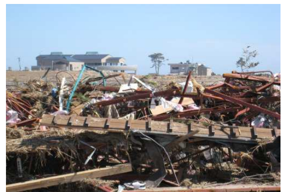
津波後の沿岸部は防災緑地公園になる
