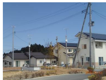
移転後、新築住宅が並ぶ
