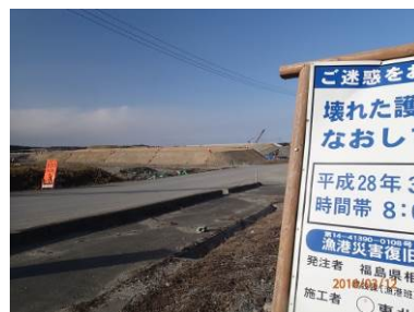
沿岸部の工事（新地町）
