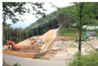
仮置き場の造成工事(信夫山)
