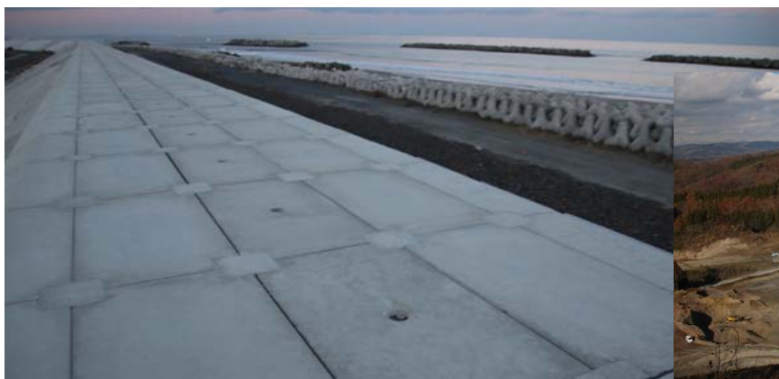
海岸線に並行して巨大な構造物を消波堤と呼び、その内側に防潮堤が築かれる (左) 箕輪峠の土砂採掘現場 (右)
