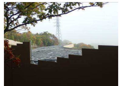
除染廃棄物仮置き場
